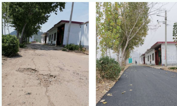
升级改造前后的乡村道路。
